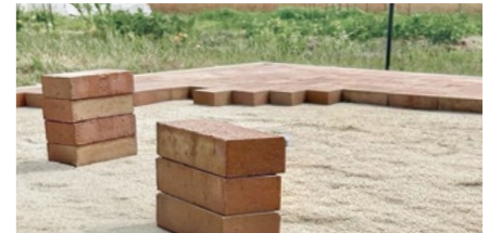
敷砂施工(砂目地 約3mm)
